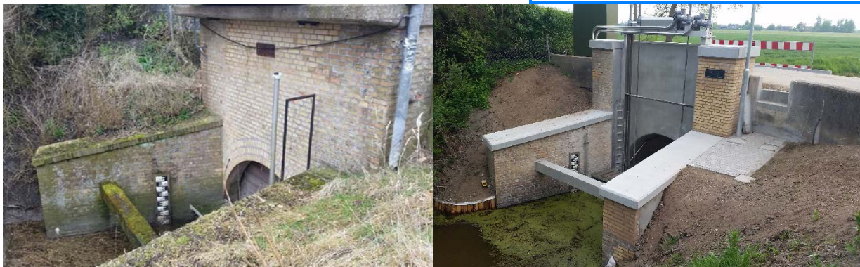
Umbau des Törpersiels mit integrierter Fernsteuerungsanlage (vorher links, nachher rechts).
